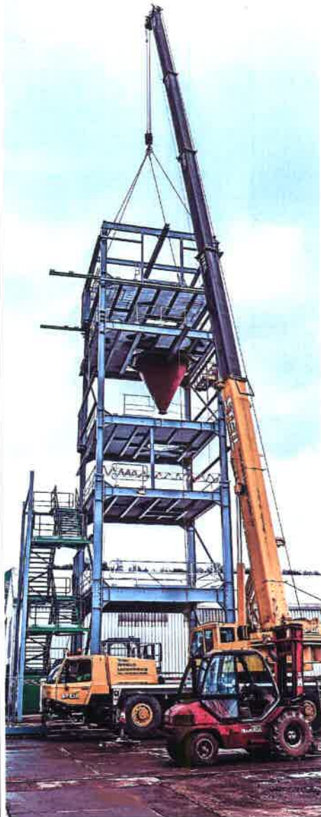
Bei der Dillinger Recycling-Firma Pyrum Innovations gab es gestern einen ungewöhnlichen Turmbau zu bestaunen. Mit einem Autokran wurde das Gerüst der geplanten Großanlage zum schadstofffreien Recycling von Altreifen aufgebaut. Der Turm hat eine Höhe von 25 Metern und wiegt über 200 Tonnen. Er besteht aus drei Einzelteilen von zehn, neun und sechs Metern Höhe. Bis Weihnachten werden noch die Treppen und Geländer montiert, außerdem wird die Anlage verkleidet. Die weltweit einmalige Anlage kann bis zu 5000 Tonnen Gummi- und Kunststoffabfälle pro Jahr verarbeiten und kostet etwa 6,5 Millionen Euro. SPK/FOTO: ROLF RUPPENSTHAL
