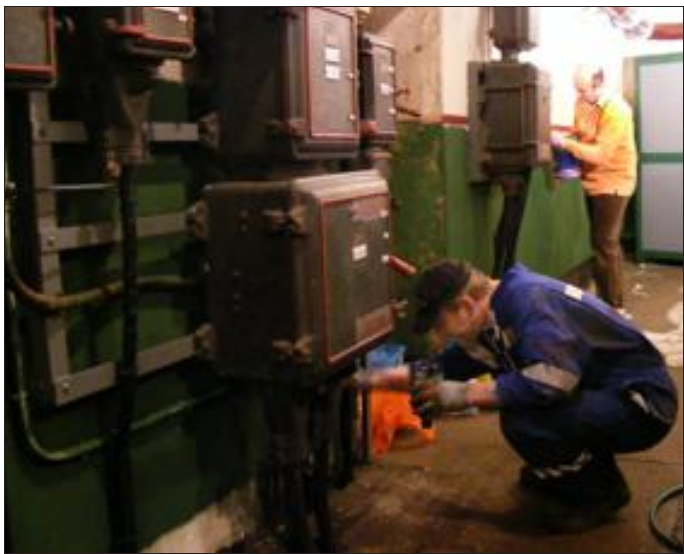
Le nouveau comité affiche ses ambitions : la rénovation générale de l'ouvrage du Bambesch ainsi que la remise à neuf de l'usine électrique et de ses peintures. Photo RL
